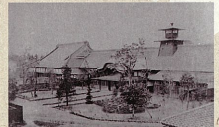
再建前橋城の本丸御殿 資料提供：宮内庁書陵部
